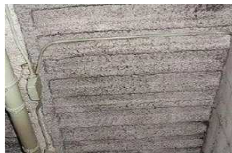
吹付け材の例(床・天井)
