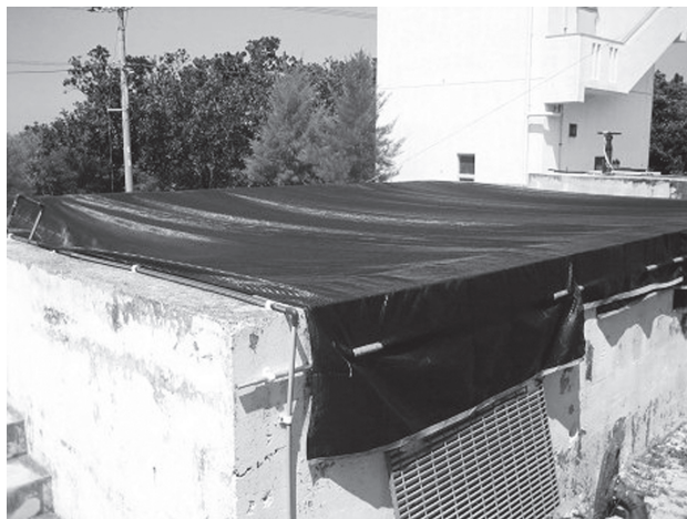
写真8. 遮光ネット設置後のB浄水場ろ過池
