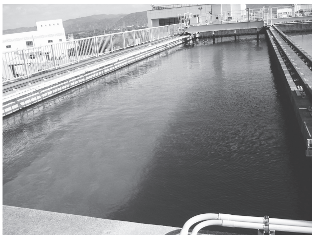
写真5. 遮光ネット設置前のA浄水場沈澱池
