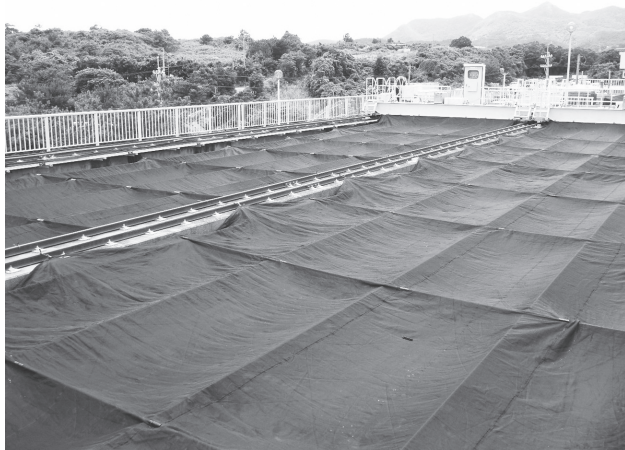
写真6. 遮光ネット設置後のA浄水場沈澱池
