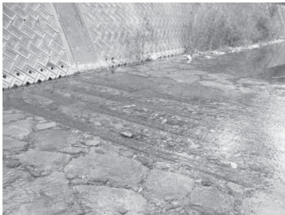
奥川本川流路工の河床の状況
