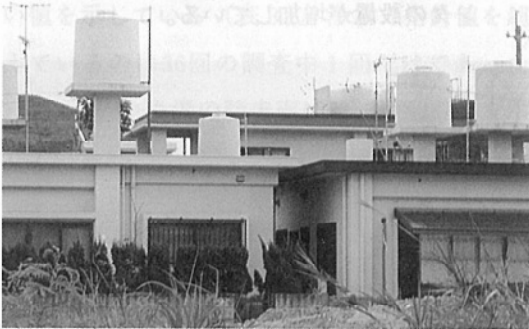
沖縄県内での水タンクの設置状況
