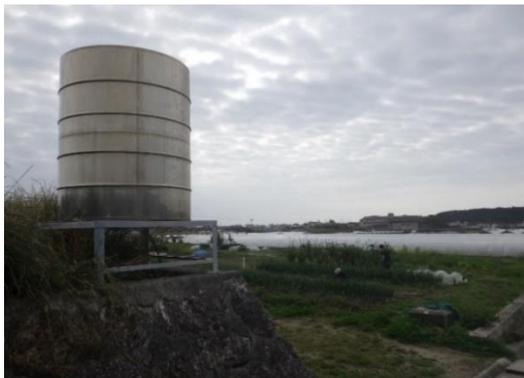
図5 種苗センターに設置した消化液貯留タンク
