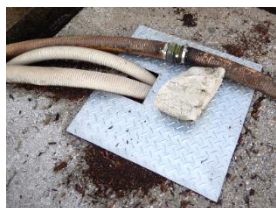
図 9 貯留槽に蓋設置
