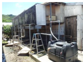
図 10 バイオフィルター設置
