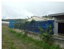
図 11 防風ネット設置
