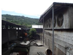
図 2 トンネル換気畜舎の排気先
