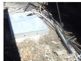
図 12 新たな集水枘及び排水ホースの設置/壊れた排水管の撤去及び汚水溜まりの埋め戻し
