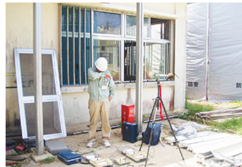
■騒音・振動調査状況
