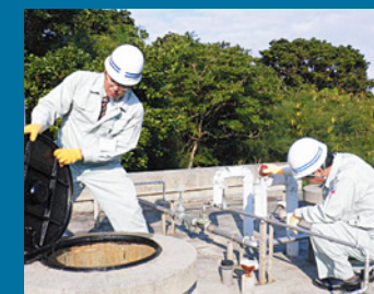
■水タンクの外観検査状況
