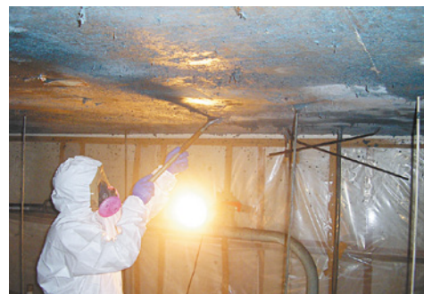
■作業環境測定状況
