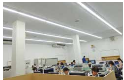
更新後の照明設備(本社)
