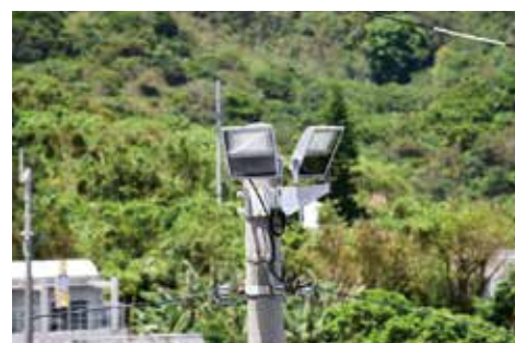
導入したLED照明
