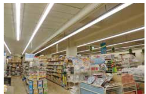
更新後の照明設備(宜野湾店)
