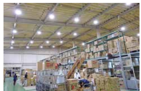
更新後の照明設備(物流センター)
