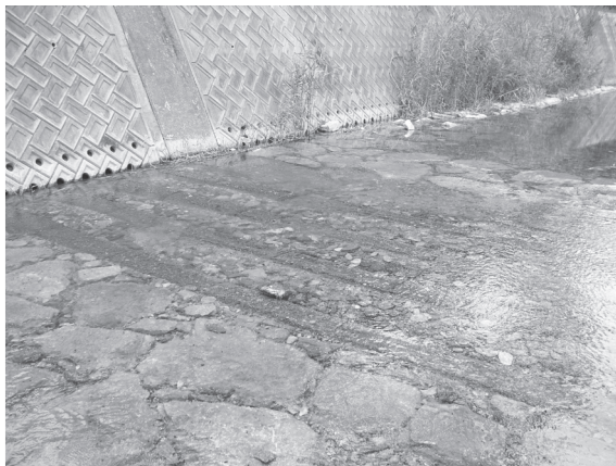
奥川本川流路工の河床の状況
