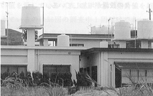
沖縄県内での水タンクの設置状況
